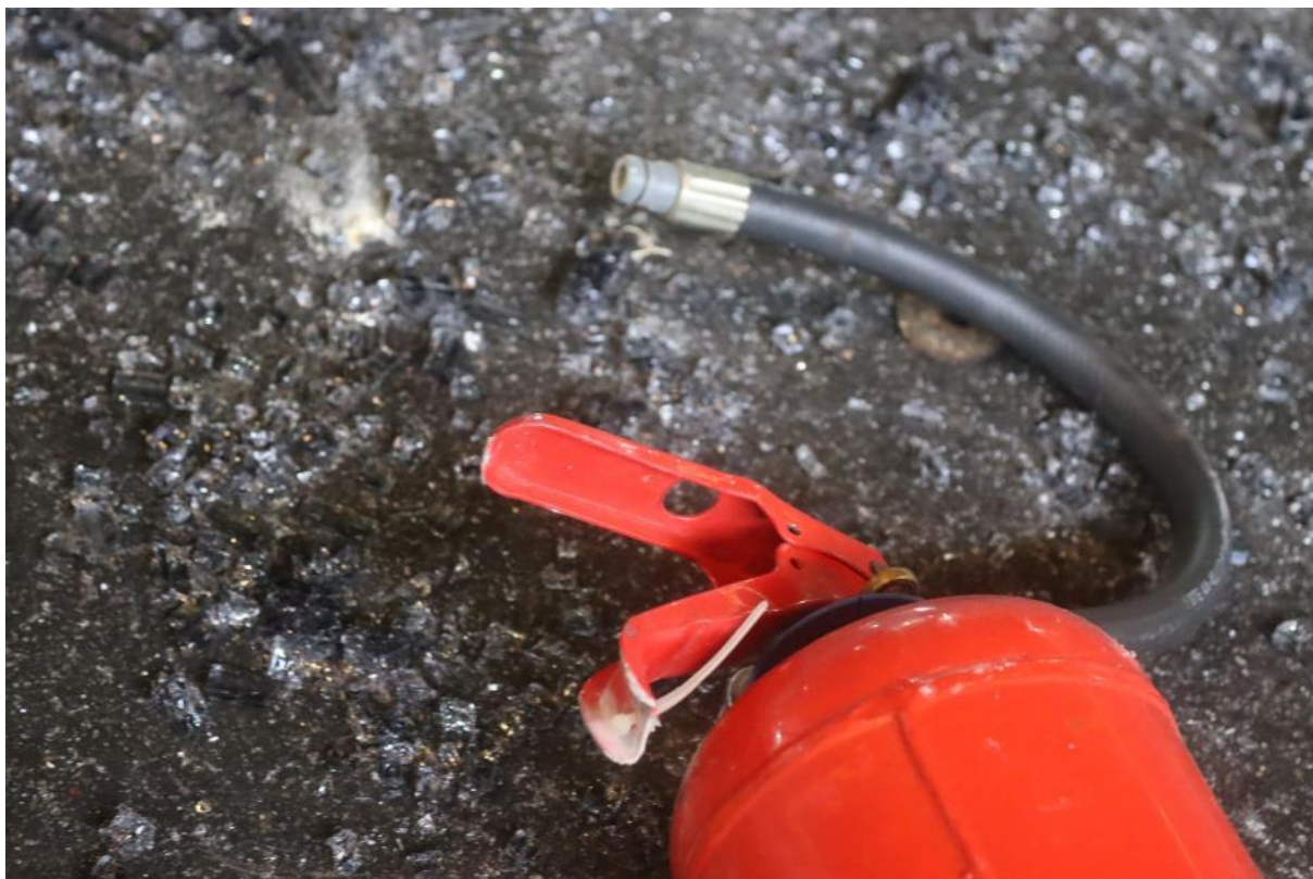
Fotografia 24 – Área de acionamento do extintor. Nota-se ausência de lacre de segurança.
